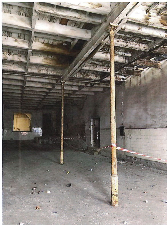
FOTO 31 | Pormenor – Pilares em Ferro | A manter / Integrar
