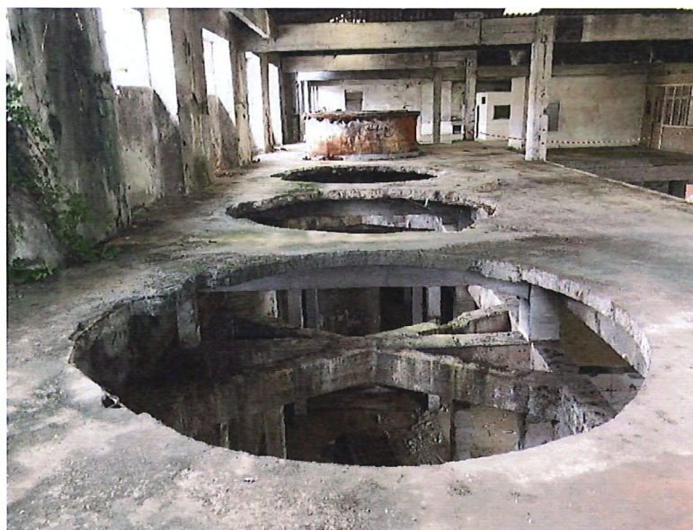
FOTO 47 | Pormenor – Estrutura de suporte de tinas
