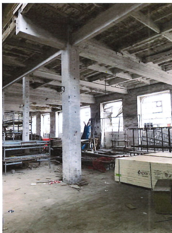
FOTO 26 | Interior – Estrutura de betão e pavimentos em madeira
